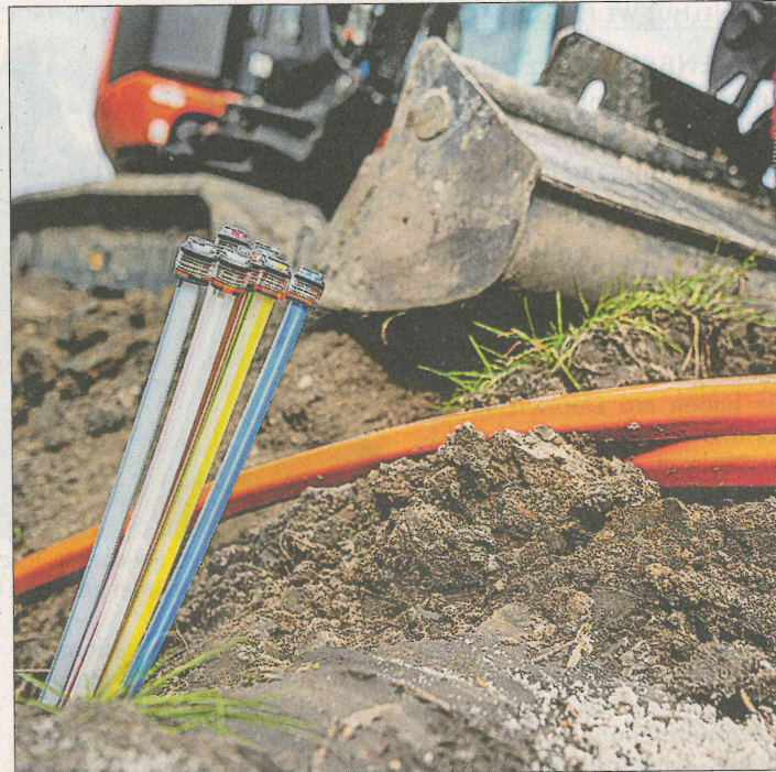
Die Arbeiten zur Verlegung des Glasfasernetzes sind kostenintensiv.
